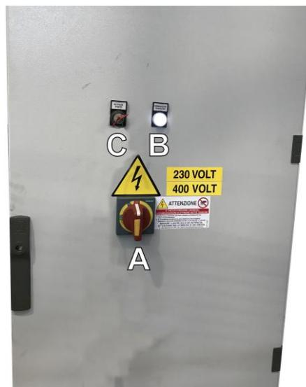
**Figura 1.4.1 – Dispositivi di comando e segnalazione dell'armadio elettrico.**
